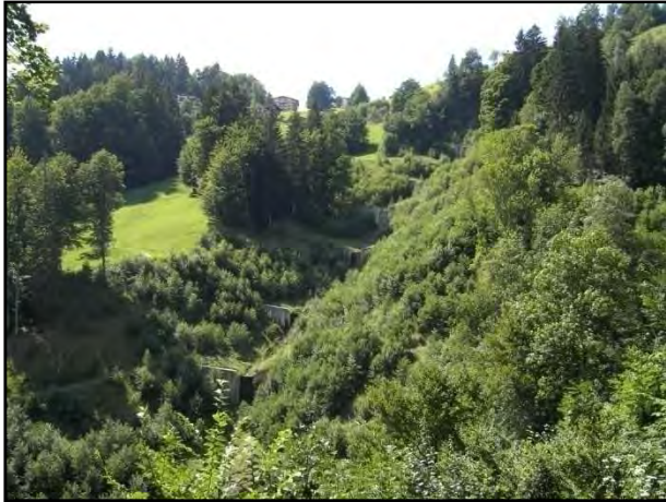
Abb.: 21: Ausgeprägte Wildbachverbauung mit mehreren Geschieberückhaltesperren.
