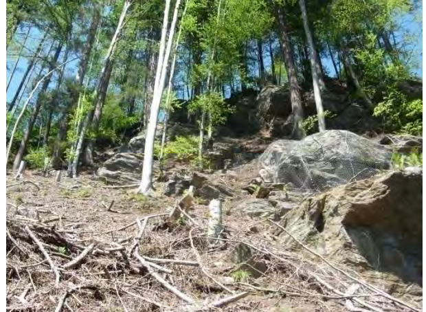
Abb.: 24: Sicherungsmaßnahmen oberhalb des Klosters Gauenstein. Mehrere m 3 große Blöcke weisen hier eine sehr exponierte Lage auf.
