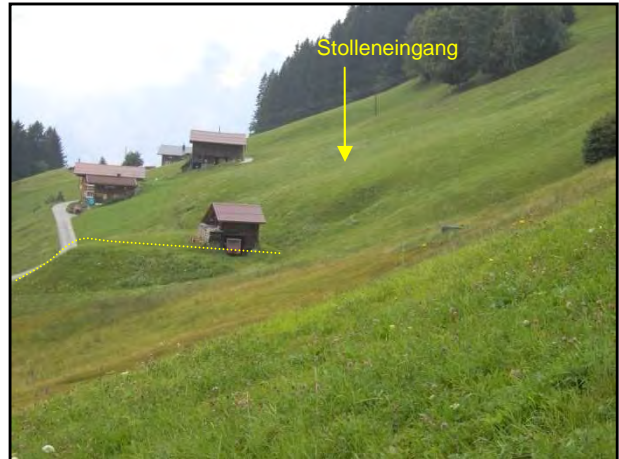
Abb.: 50: Auf Grund der abgeflachten Topographie sowie der guten Standfestigkeit der Halden wurden diese gerne für Gebäude verwendet. Unterhalb des Stadels ist die steile Front der Halde noch gut erkennbar sowie der bergseitige Verbruch des einstigen Stollens. Blick Richtung Walgau.
